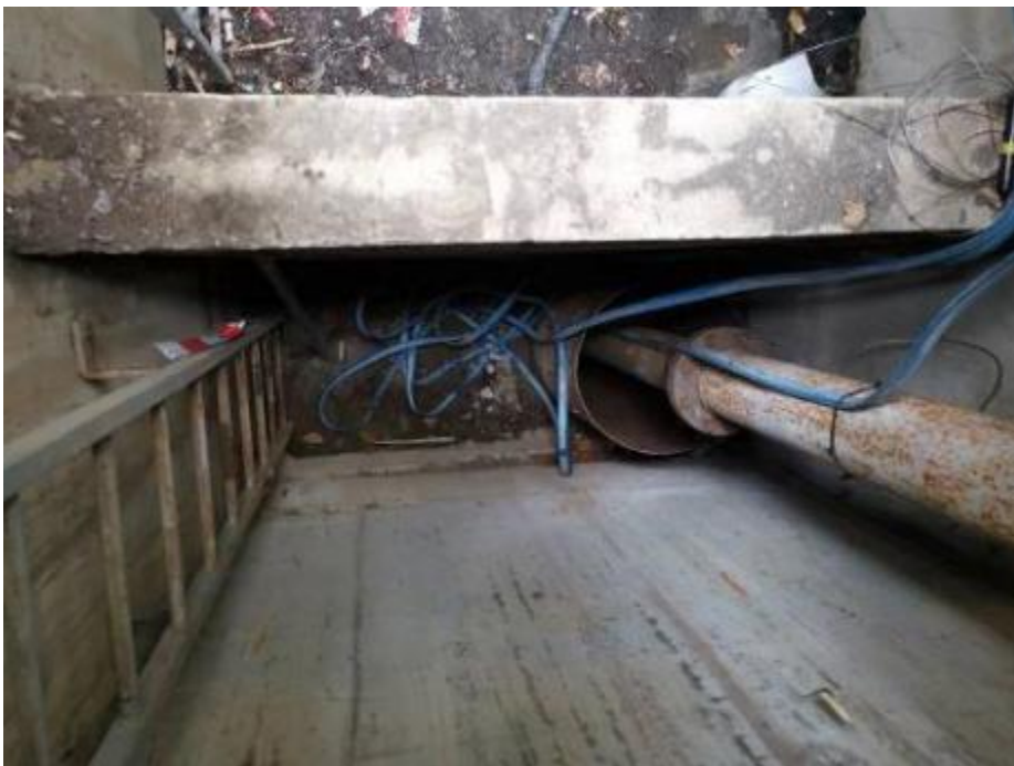
Tête du forage avant mise en place des demi-cloches de protection
