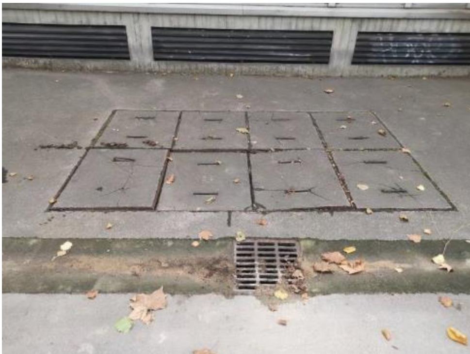
Vue d'ensemble de la tête de forage sur le trottoir - Rue du Général Dayan, fermée par des trappes en béton non étanches, amovibles
